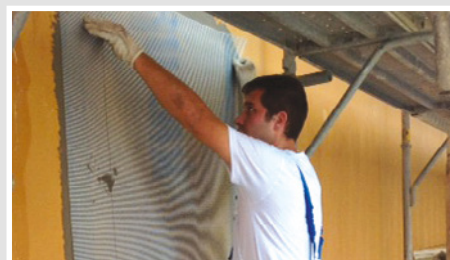
Stesura della rete di armatura
